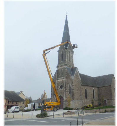
Travaux sur le clocher de l'église
