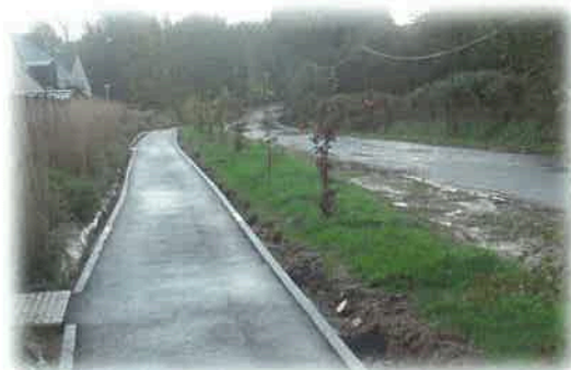
Rue de La Chesnais en travaux
