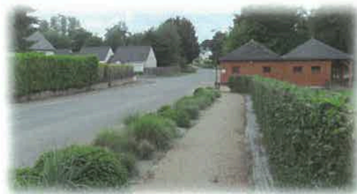
Rue de La Chesnais avant travaux
